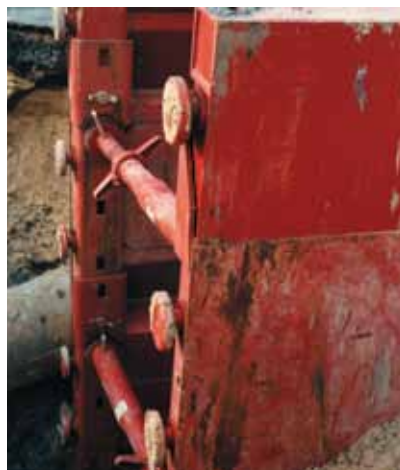
Los codales se pueden colocar en la guía deslizante o en los paneles. De este modo se puede evitar el uso de guías al principio al final de la zanja.
