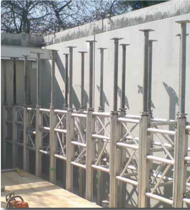
Puntales Alu-TITAN HV, arriostrados con bastidores Alu-TITAN
