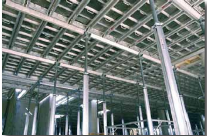
Puntales Alu-TITAN HV soportando un encofrado de losas TITAN-HV
