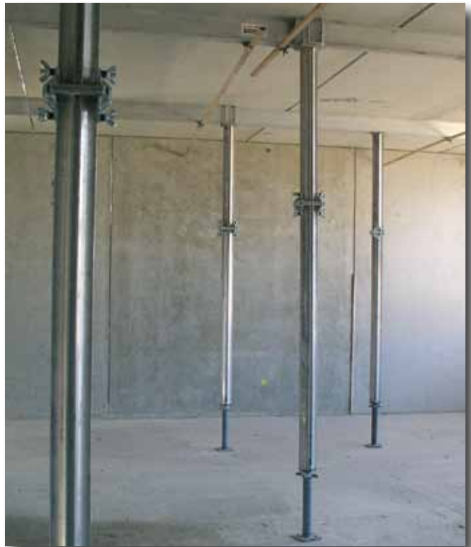
Puntales Alu-TITAN HV con prolongador para apoyar elementos de losas prefabricadas
