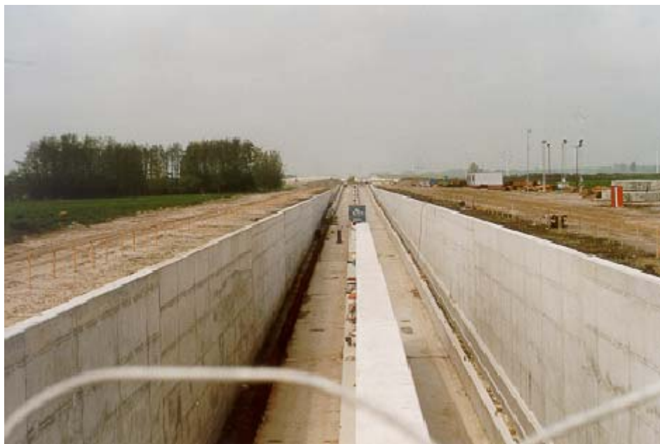
Rampa del túnel terminada
