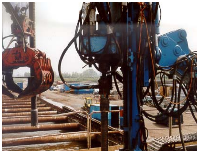
Aporte de barras mediante grúa a la máquina perforadora
